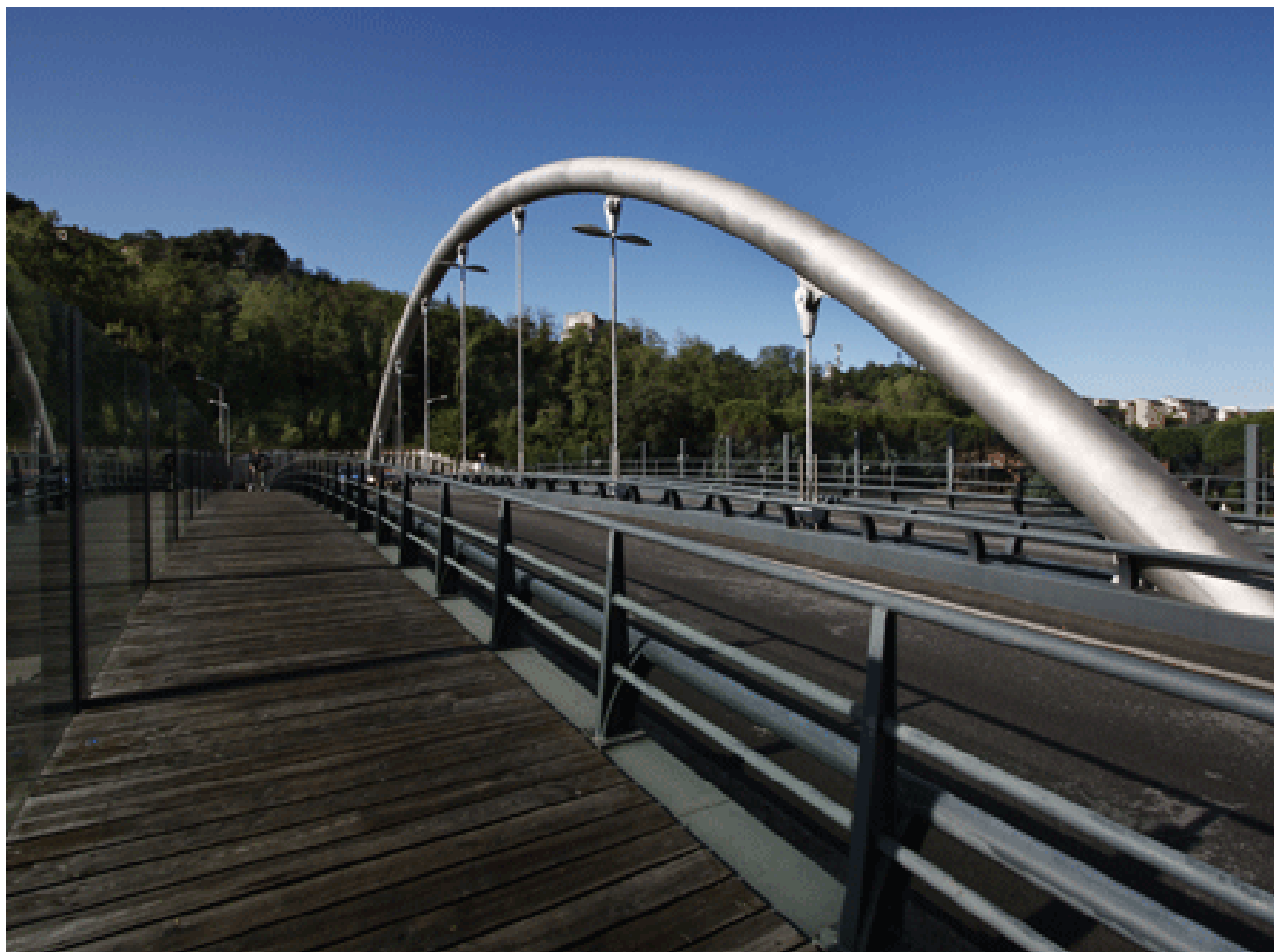
Fig. 4. Arco di Malizia Bridge in Siena (Italy) [7]
